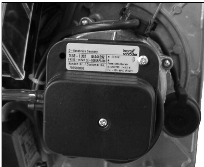
Рис. 8: Реле давления воздуха
