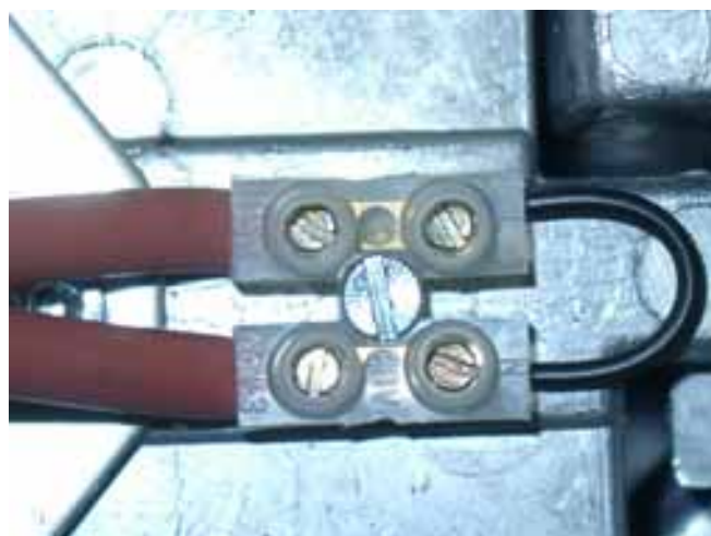
Рис. 26: Перемычка для измерения ионизационного тока
